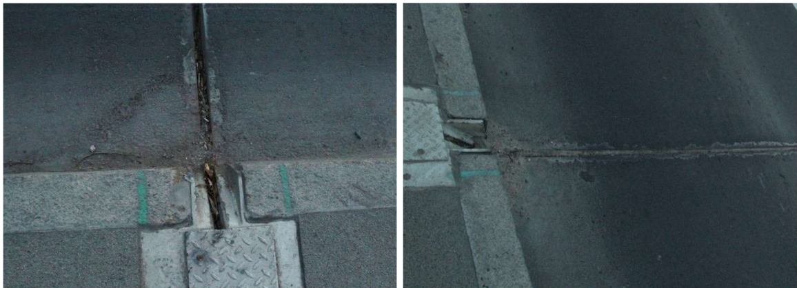
Fot. 70 Widok na strefy dylatacyjne
