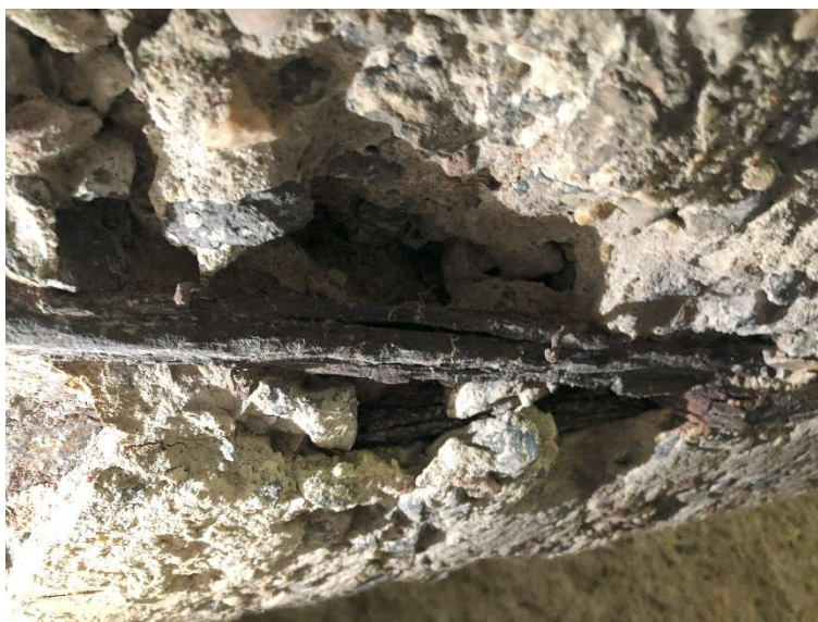
Fot. 37 Silna korozja zbrojenia dźwigara w strefie zakotwień
