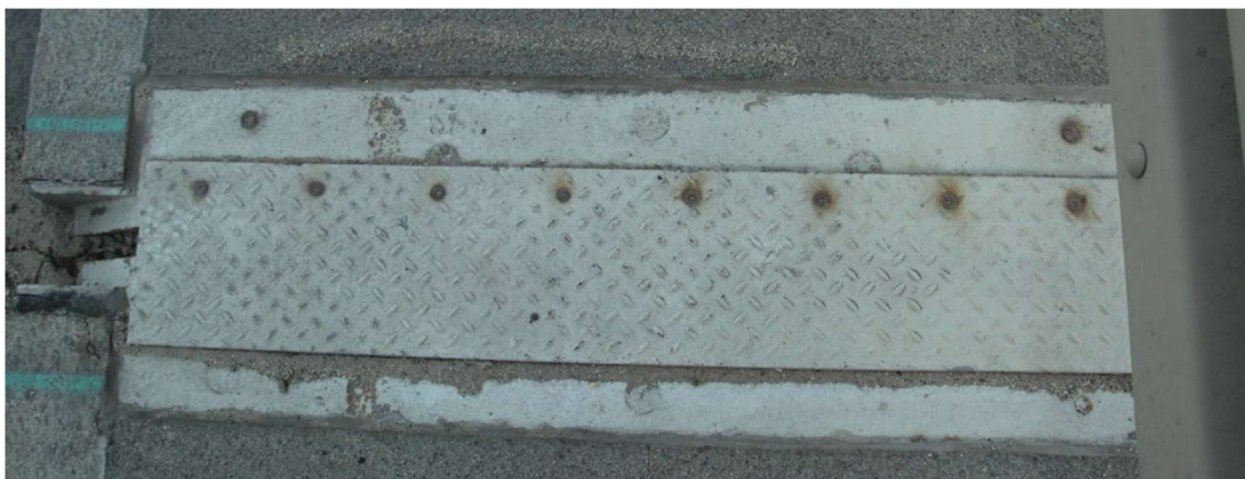
Fot. 76 Kapa chodnikowa w strefie dylatacji – korozja śrub
