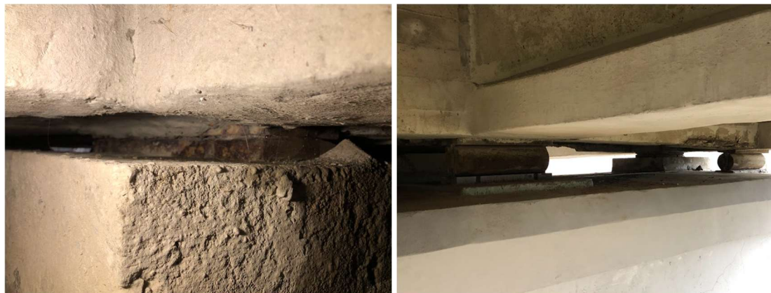
Fot. 8 Widok na łożyska – przyczółek oraz filar
