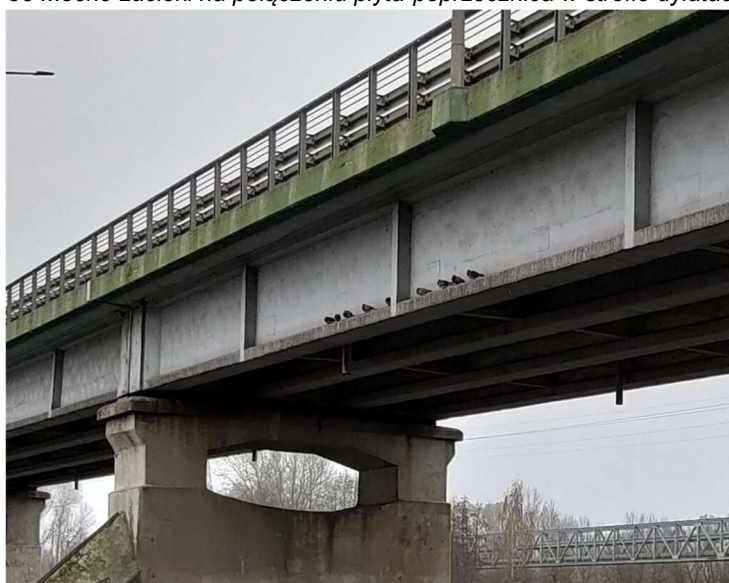
Fot. 39 Geometria belek sprzyjająca siedliskom ptaków
