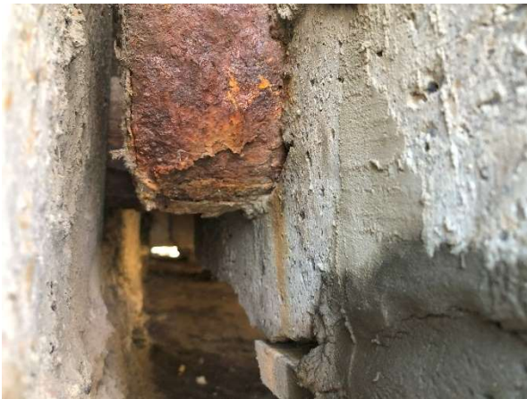
Fot. 34 Widok na kotwienie kabli sprężenia dźwigara w osi 1
