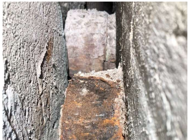
Fot. 35 Widok na kotwienie kabli sprężenia dźwigara w osi 1
