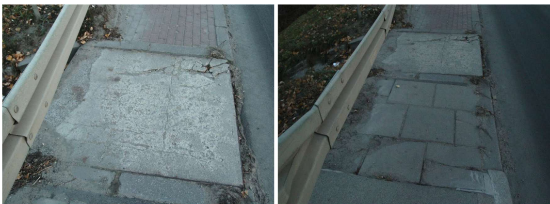
Fot. 77 Połączenie nawierzchni na dojeździe do obiektu z kapą na obiekcie (z lewej przykrycie cieku)
