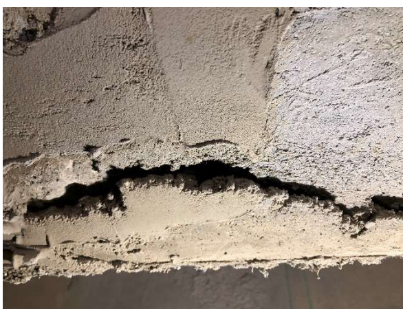
Fot. 41 Odspojenie zapraw na poprzecznicy w osi 1
