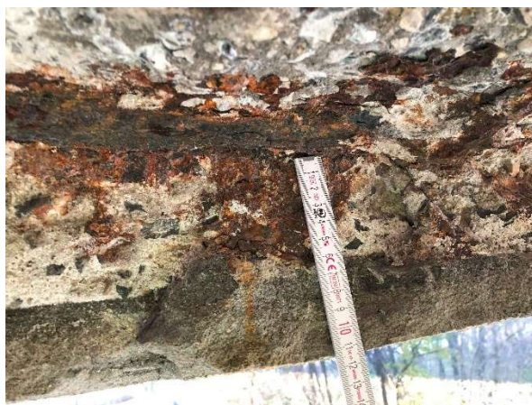
Fot. 58 Podpora pośrednia w osi 3 – otulina
