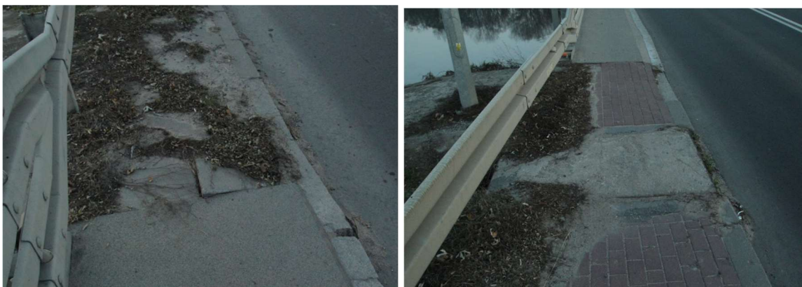
Fot. 78 Połączenie nawierzchni na dojeździe do obiektu z kapą na obiekcie
