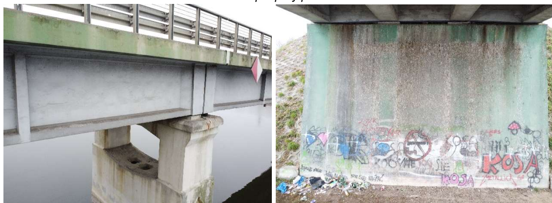
Fot. 7 Widok na komorę minerską z lewej i przyczółek mostu z prawej
