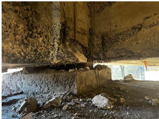
Fot. 65 Łożysko stalowe na podporze pośredniej w osi 2
