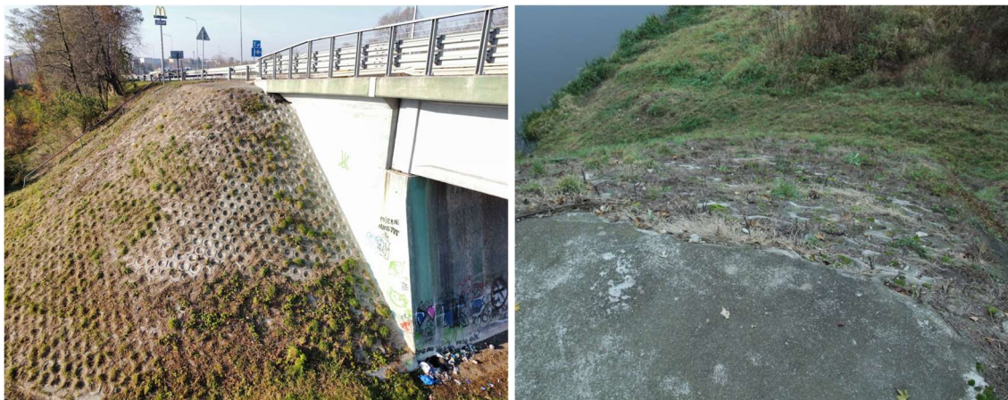
Fot. 95 Skarpa umocniona
