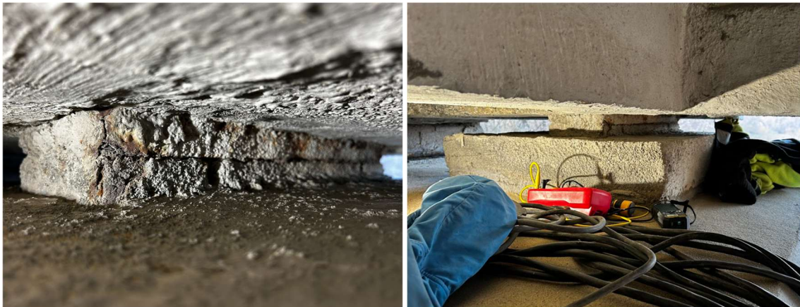
Fot. 64 Łożyska na podporach pośrednich
