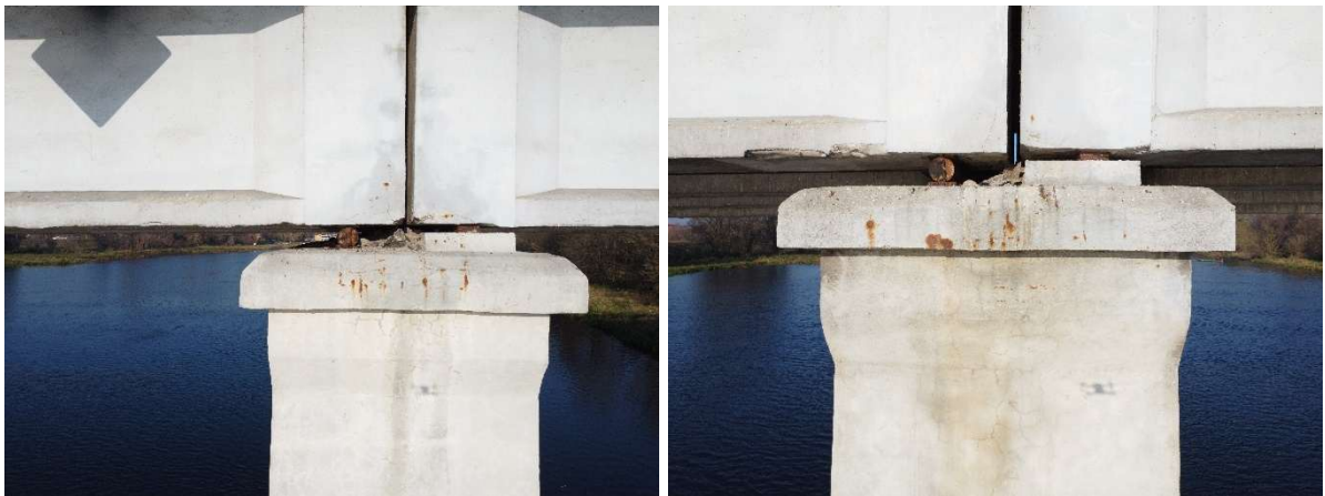
Fot. 63 Widok na strefę łożysk (z lewej obrót 0° w osi 6, z prawej prawidłowy obrót w osi 7)
