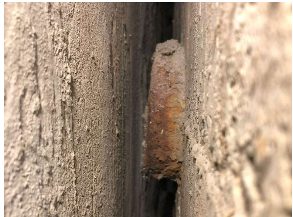
Fot. 34 Widok na kotwienie kabli sprężenia dźwigara w osi 1
