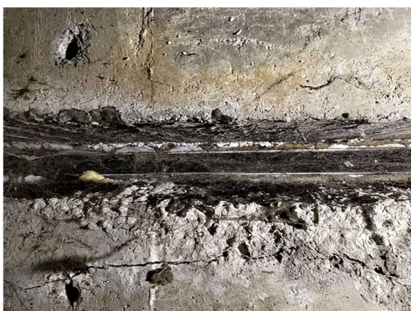
Fot. 40 Widok na urządzenie dylatacyjne od spodu
