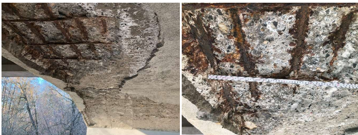
Fot. 57 Podpora pośrednia w osi 3 – oczep podłożyskowy
