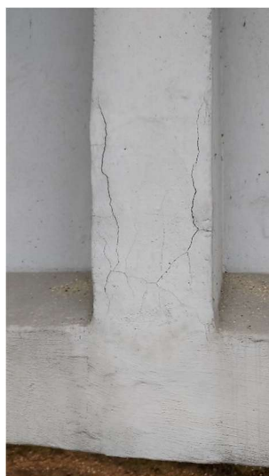
Fot. 42 Zarysowanie poprzecznicy w strefie zakotwienia kabli
