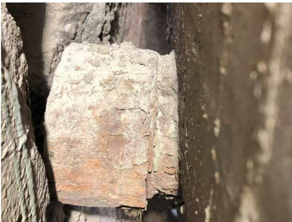
Fot. 35 Widok na kotwienie kabli sprężenia dźwigara w osi 1
