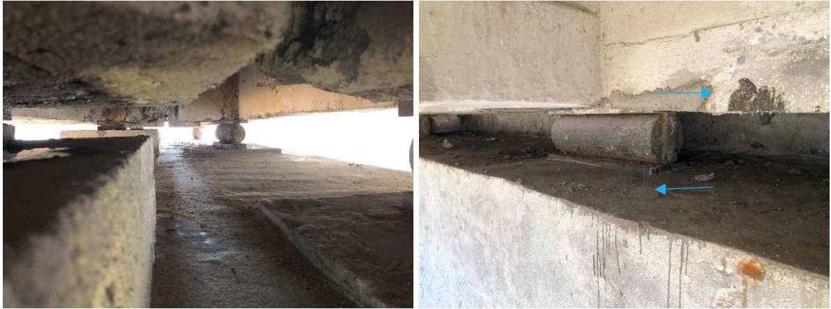
Fot. 62 Widok na strefę łożysk (z lewej prawidłowy obrót w osi 3, z prawej nieprawidłowy w osi 1)
