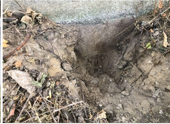
Fot. 49 Odkrywka fundamentu w osi 4
