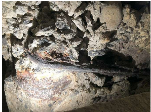
Fot. 36 Widok na zakończenie dźwigara w strefie zakotwień
