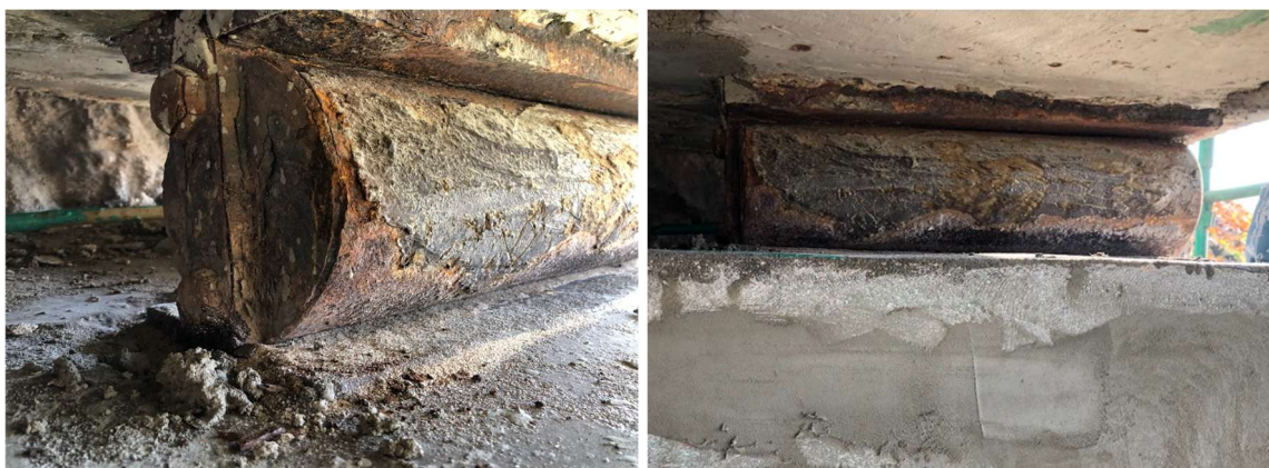
Fot. 60 Łożyska walcowe - korozja
